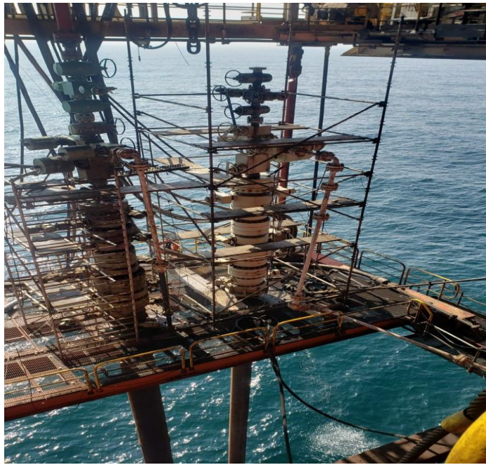
Figura 2. fotografía representativa de pozos exploratorios perforados produciendo con un drenaje simultáneo sin una estructura fija (Pozos exploratorios HPHT subsalinos con objetivos Mesozoicos)
